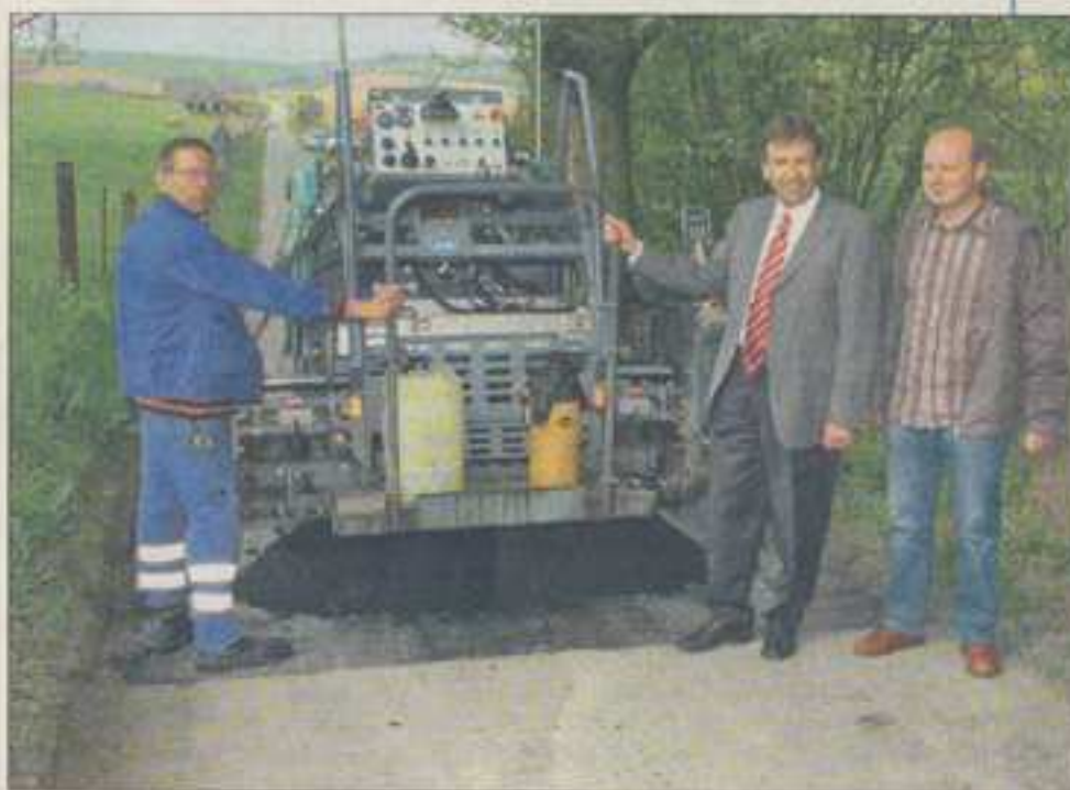
Matthias Streich (Baufirma Schönhoff), Friedhelm Spieker und Ansgar Kleibrink (von links) auf der Baustelle in Brakel-Hembsen. Gerade wird die
