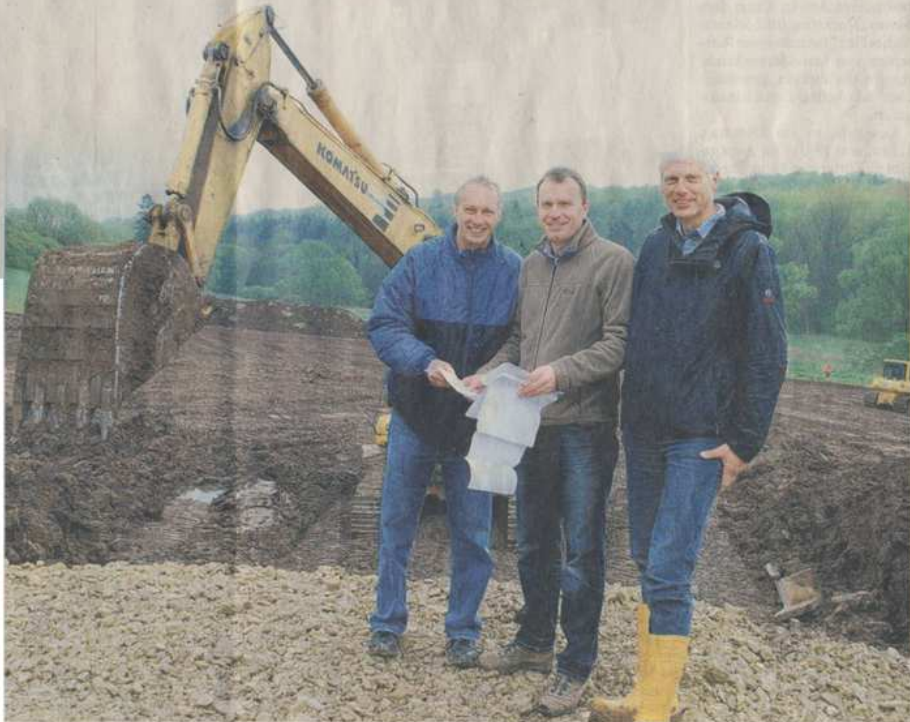
Auf der Baustelle: Ulrich Schobeit (Planungsbüro Turk), Klaus Zimmermann und Bauunternehmer Johannes Schönhoff (v. l.) inspizierten gestern Vormittag den Fortschritt der Erdarbeiten.
