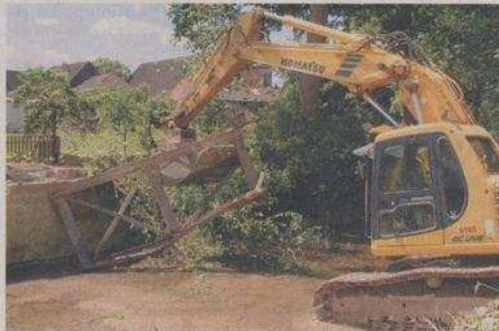
Langer Arm: Bei extremem Niedrigwasser holt Baggerfahrer Günter Ladage die alte Brückenkonstruktion aus der Emmer. FOTO: JOSEF KÖHNE
