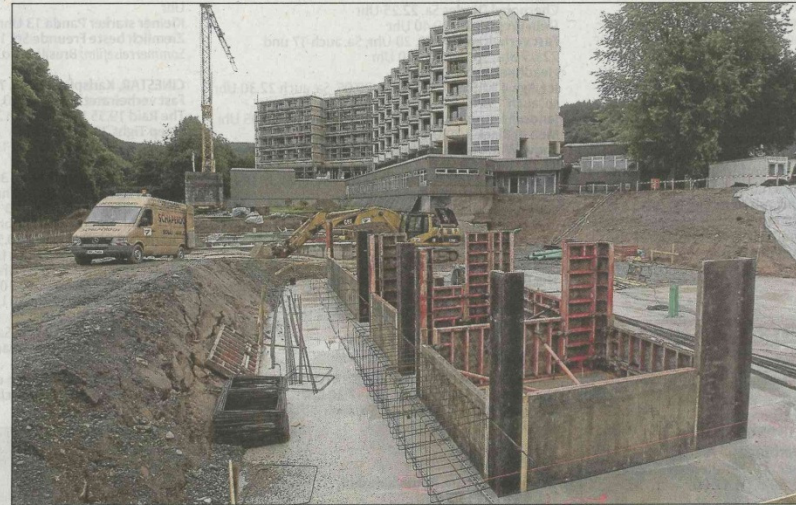
Die aufwändige Gründung ist schon weit fortgeschritten. Der Anbau wird wegen der Überschwemmungsgefahr nahe der Weser auf ein sogenanntes Luftgeschoss, das heißt auf Ständer gesetzt. Fotos: Thiele
