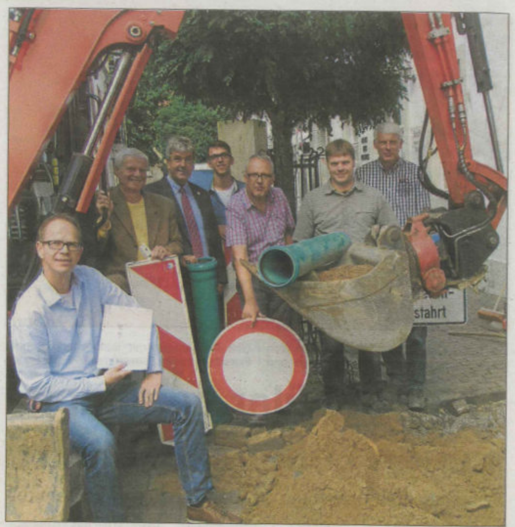
Alexander Frewer (von links), Dr. Werner Schwarz, Bürgermeister Hermann Remme, Tobias Bielefeld vom Ingenieur-Büro Turk, Johannes Groppe, Christoph Müns- termann und Bauunternehmer Johannes Schönhoff neben der ersten Baustelle am Haus des Gastes. Auch hier sind Rohre ausgetauscht worden. Foto: Reinhold Budde
